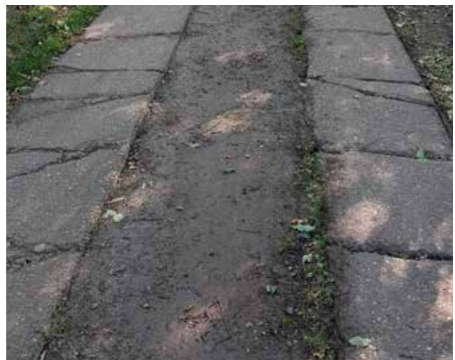
Beschädigte Betonplatten
