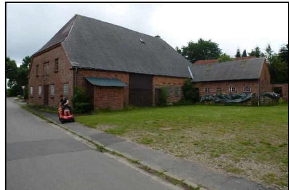
Stallgebäude am Rolfshörner Weg
